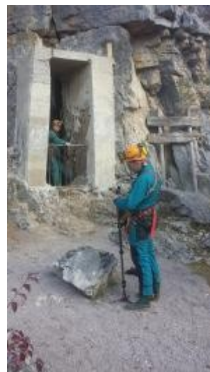
Une entrée toute neuve pour la Combe aux Prêtres
